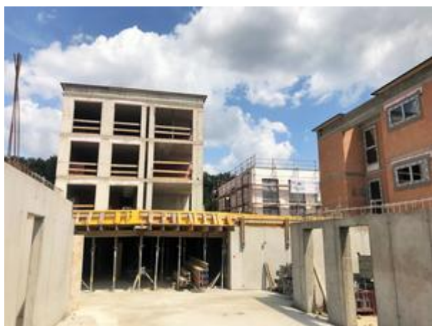
Blick auf Tiefgarage
