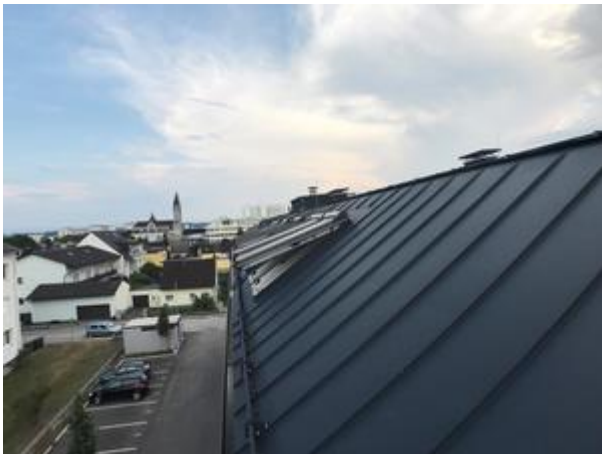
seitl. Ansicht Dachfenster
