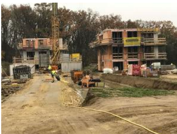
Baufortschritt November Haus 3 u. 6 Rohbau
