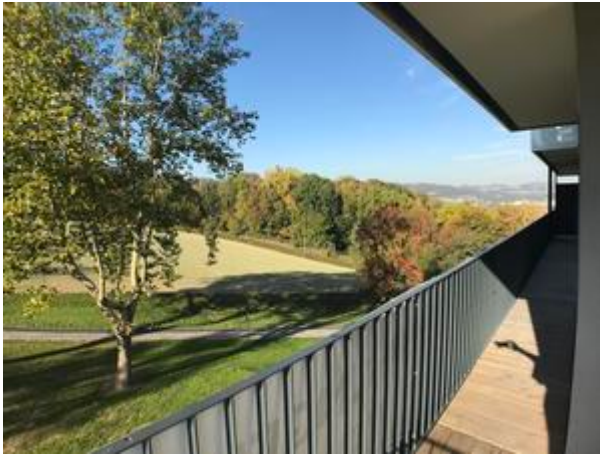
Balkon alle Schlafräume und Bad
